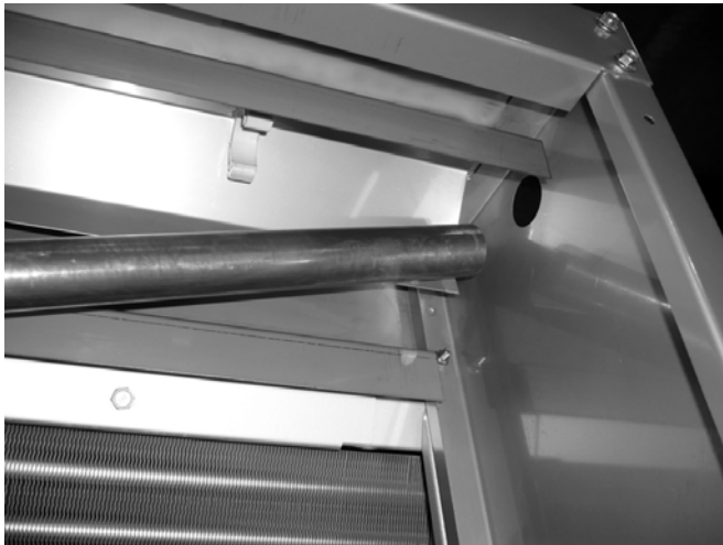
Figure 12: Installation du tube en cuivre d'alimentation en eau
