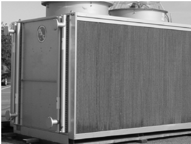
Figure 17: Appareil avec le média de pré-refroidissement adiabatique installé
