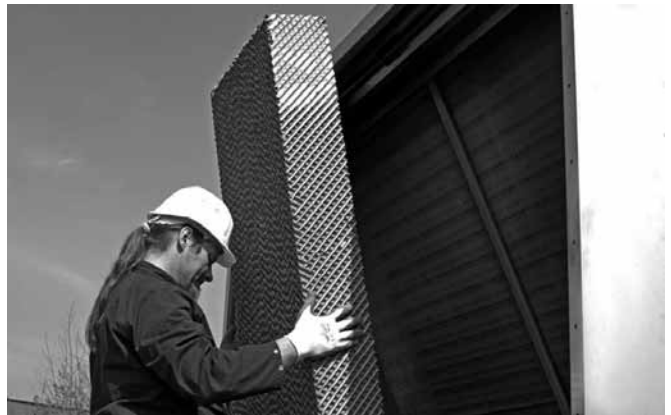
Figure 20: Démontage du média de pré-refroidissement
