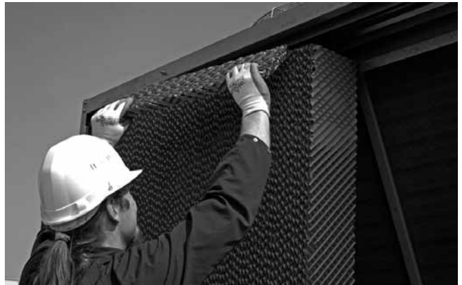
Figure 19: Démontage du média de distribution d'eau
