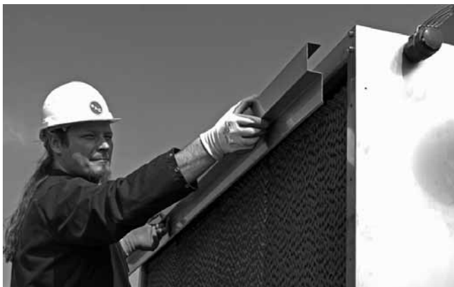
Figure 18: Démontage de la plaque supérieure
