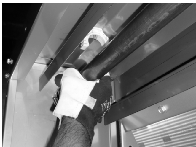
Figure 7: Libération du collecteur en cuivre des supports en plastique
