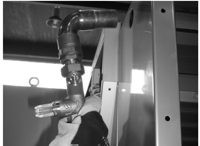
Figure 14: Ensemble d'alimentation en eau
