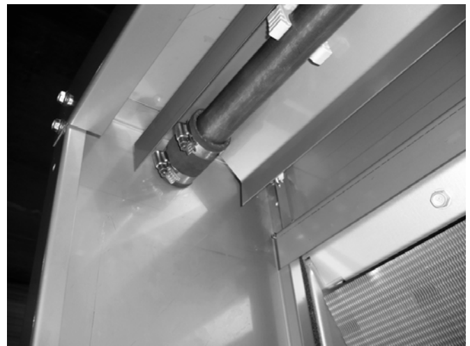
Figure 15: Manchon élastique de raccordement avec colliers de serrage
