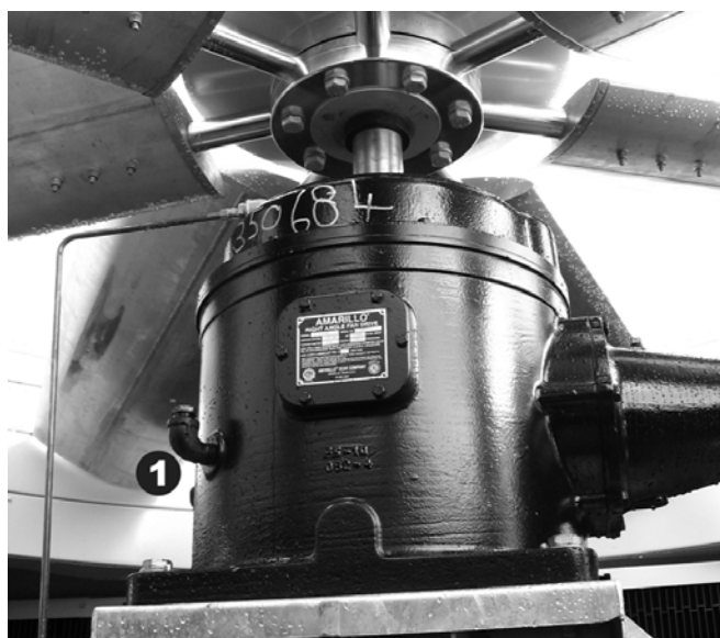
Figure 8: Réducteurs renvoi d'angle simples
