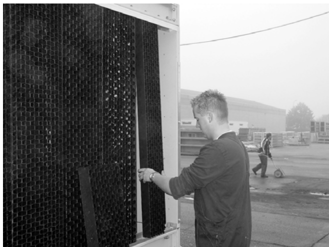
Figure 11: Démontage des déflecteurs d'entrée d'air
