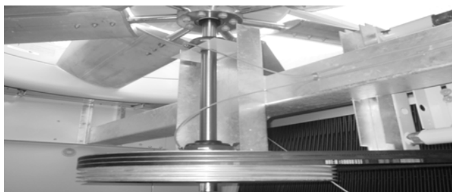
Figure 12: Arbre de ventilateur
