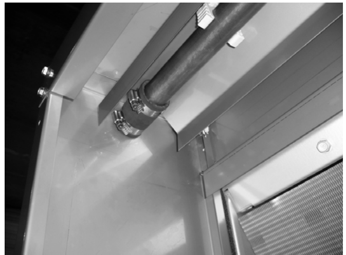
Figure 16: Manchon élastique de raccordement avec colliers de serrage
