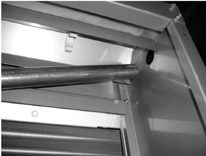
Figure 13: Installation du tube en cuivre d'alimentation en eau
