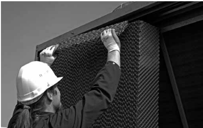
Figure 20: Démontage du média de distribution d'eau
