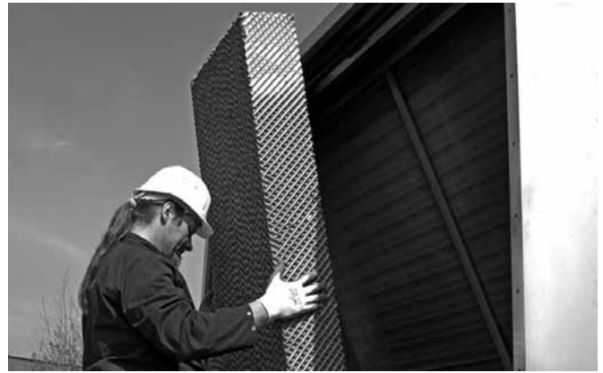
Figure 21: Démontage du média de pré-refroidissement
