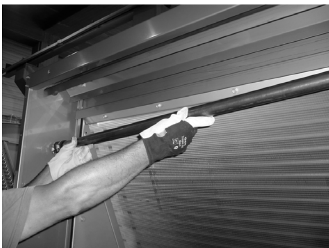
Figure 9: Démontage du tube en cuivre d'alimentation en eau
