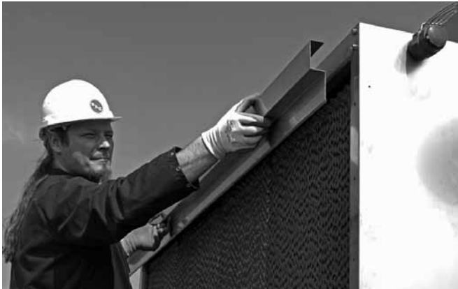
Figure 19: Démontage de la plaque supérieure
