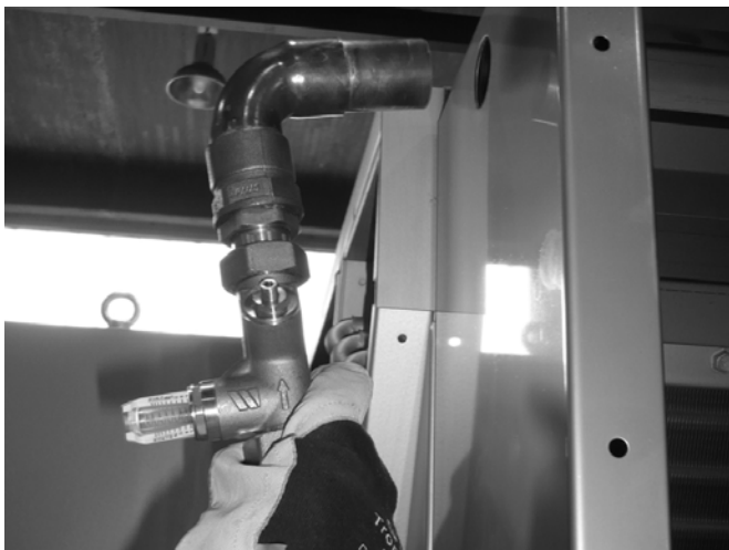
Figure 7: Raccordement de l'alimentation en eau
