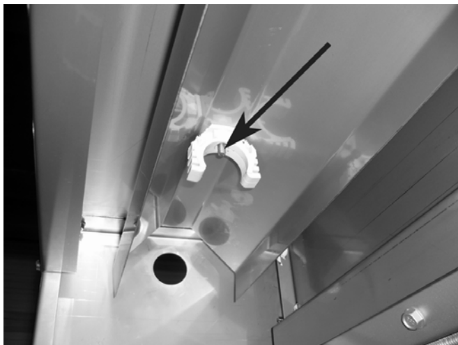
Figure 12: Support en plastique doté d'une plus longue vis
