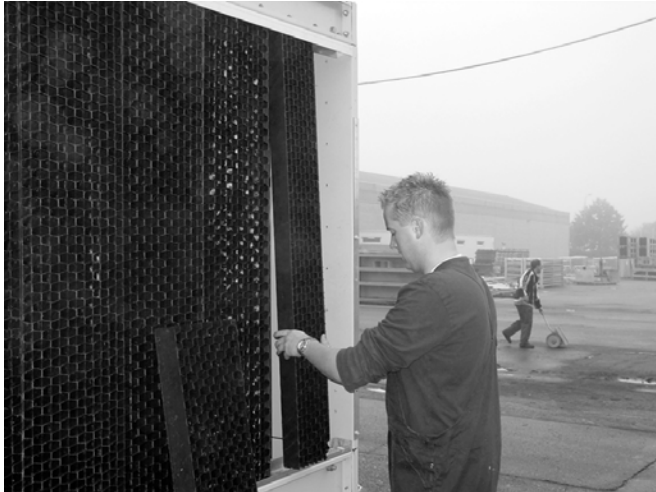
Figure 10: Démontage des déflecteurs d'entrée d'air
