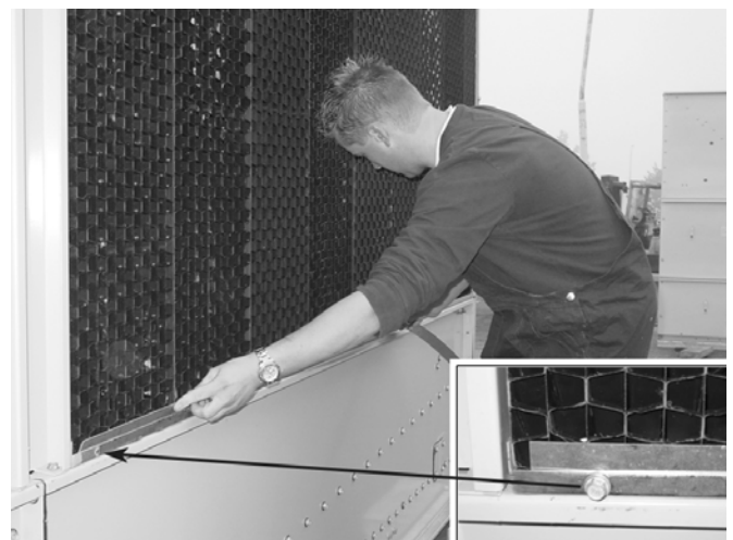
Figure 9: Démontage des sangles d'expédition
