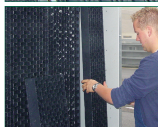
Déflecteurs d'entrée d'air à 3 fonctions faciles à démonter
